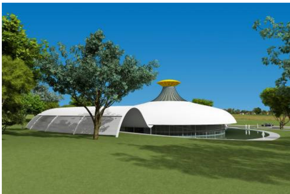
Figura 22 – A luz penetra através dos brises metálicos situados na parte posterior do anfiteatro.
