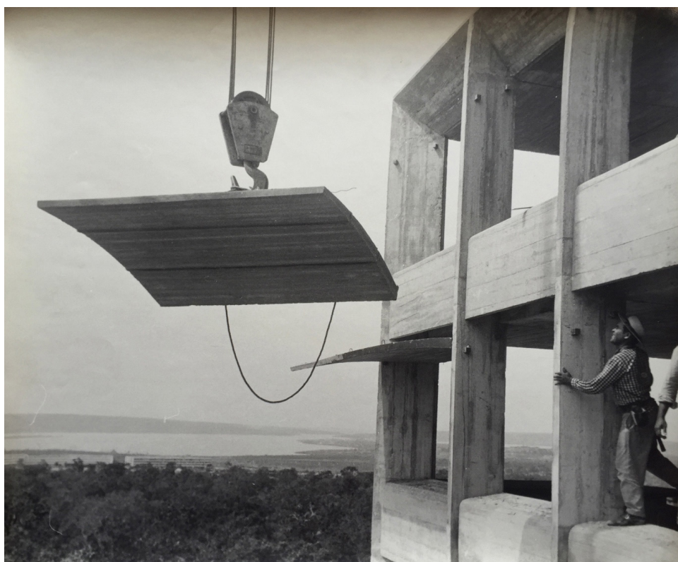
Figura 8 – Sede da concessionária Disbrave. Processo de montagem do brise-soleil pré-moldado. João Filgueiras Lima, 1965, Brasília. Fotografia Marcel Gautherot. Arquivo João Filgueiras Lima, Salvador.
