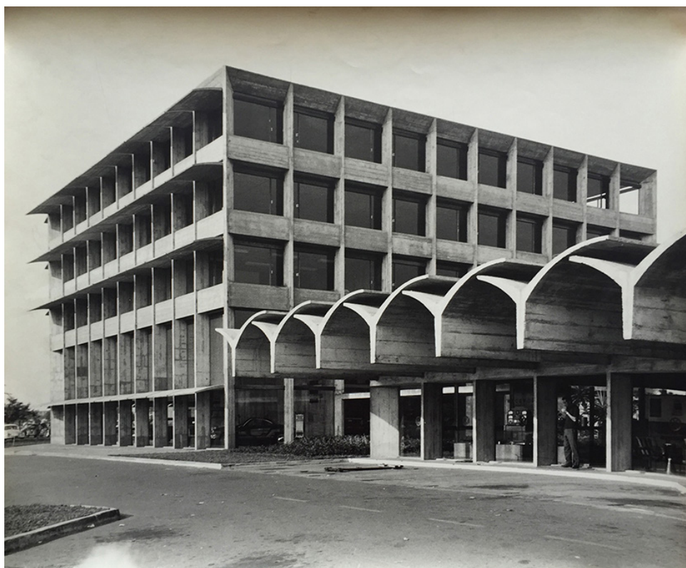
Figura 6 – Sede da concessionária Disbrave. Vista do bloco administrativo. João Filgueiras Lima, 1965, Brasília. Fotografia Marcel Gautherot. Arquivo João Filgueiras Lima, Salvador.
