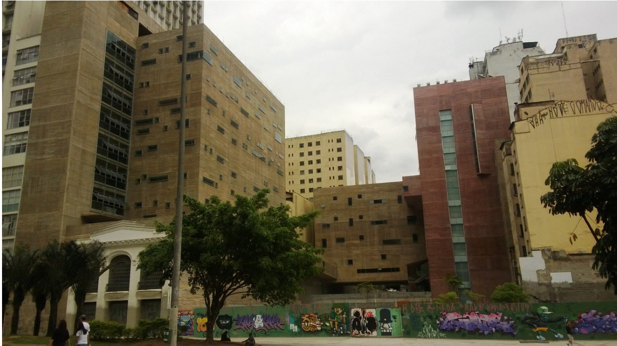
Figura 01 Praça das Artes - Vista da Rua Formosa Fonte: Masao Kamita
