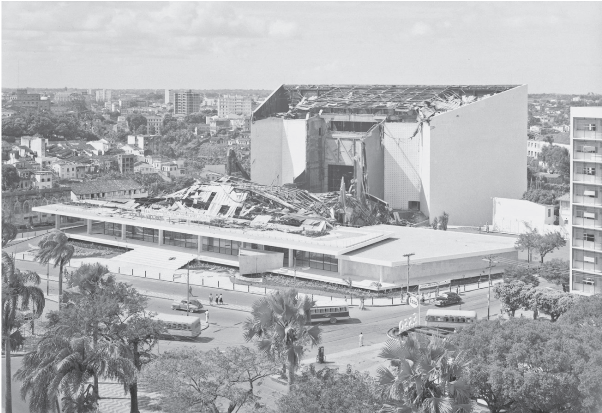
Figura 3 Teatro Castro Alves (José Bina Fonyat Filho, 1957-1967). Foto datada de 11 de julho de 1958, dois dias após o incêndio que o destruiu Fonte: Acervo do Centro de Documentação e Referência da Odebrecht, Salvador
