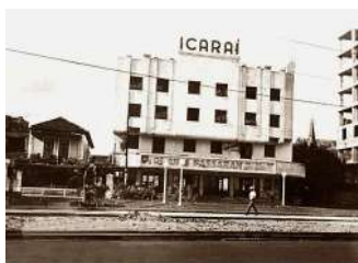
Figura 4: Fachada Art Decó do Cinema Icarai. Fonte: opolifônico.wordpress.com (2018)
