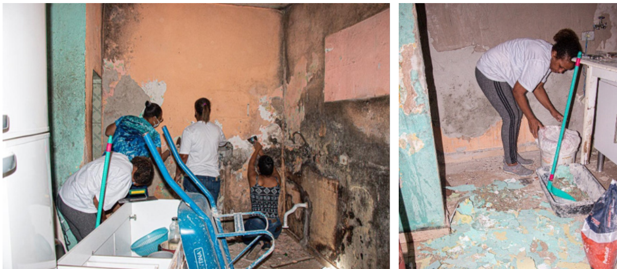
Figura 3 Aplicação prática das aulas de impermeabilização, outubro de 2022 Fonte: Instituto Fazendinho
