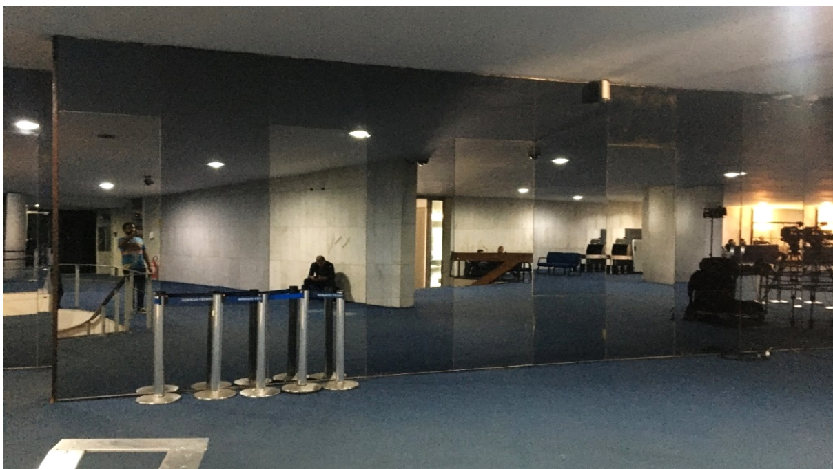
Figura 16: Painel de espelhos fumê do Salão Azul, após recomposição com peças de tom ligeiramente diferente. Fonte: Senado Federal / Sinfra (2023).
