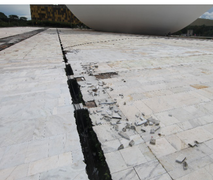
Figuras 04, 05 e 06: Edifício Principal. Cobertura. Danos ao longo de calha; Edifício Principal. Salão Negro. Piso em granito negro arranhado; Edifício Principal. Salão Nobre. Mancha branca no piso. Fonte: Senado Federal / Sinfra (2023).
