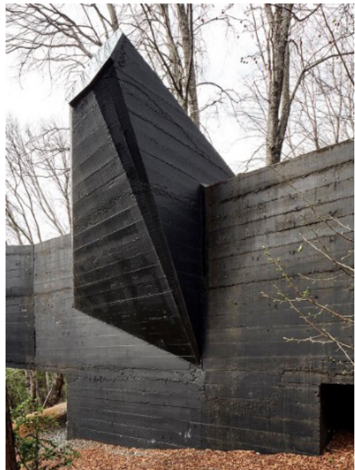
Figuras 16 e 17 à esquerda, varanda periférica e perímetro envidraçado da Casa en Portezuelo, de Miguel Eyquem; à direita, perímetro opaco em concreto aparente pintado de preto, com clarabóia em formato de tronco de cone na Casa para el Poema del Ángulo Recto, de Smiljan Radić. Fonte: In Lieblicher..., 2020 e Cristobal Palma, fotógrafo.
