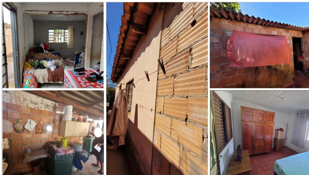
Figura 04 Exemplos de reformas espontâneas realizadas pelos moradores dos estudos de caso, sem acompanhamento técnico. Fonte: Autoras.
