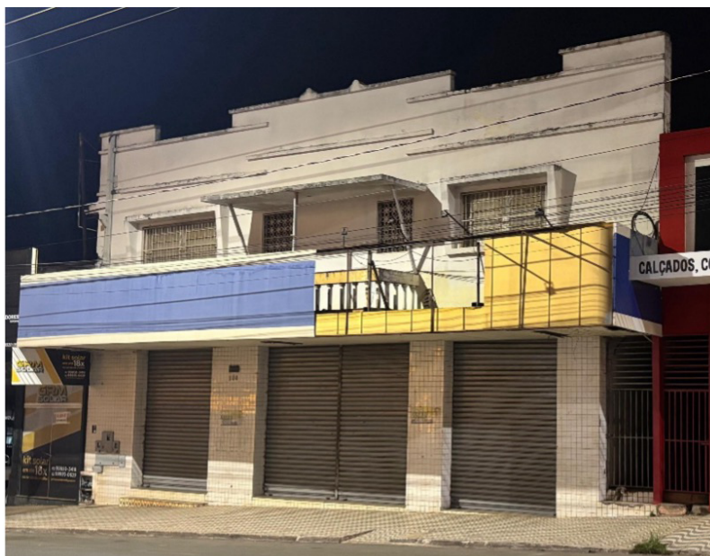
Figura 2 Fachada do antigo cinema Cine Caiçara em Uruaçu (GO), 2025. Fonte: Acervo pessoal da autora, 2025.
