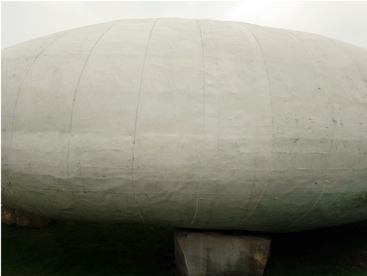
Figura 09 Detalhe do Pavilhão da Serpentine Gallery – casca em fibra de vidro. Fonte: Matias Baumann, 2019.
