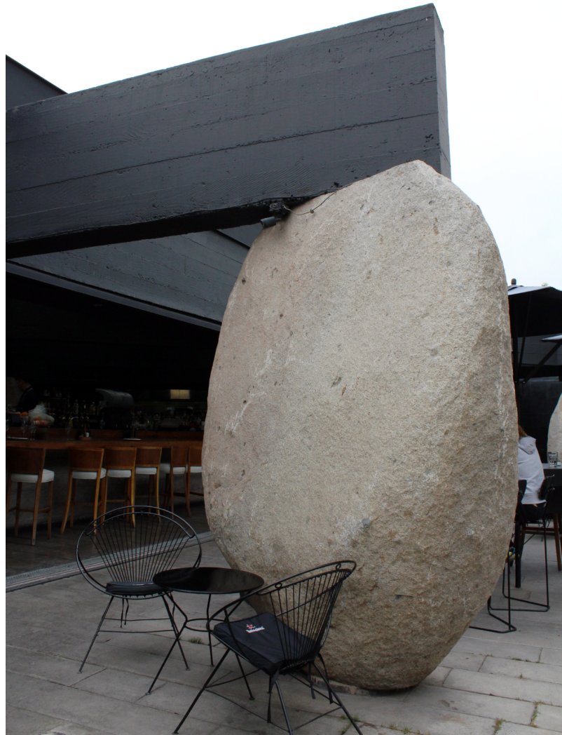
Figura 05 Detalhe do viga mento apoiado sobre a pedra maior junto à entrada do Restaurante Mestizo. Fonte: Matias Baumann, 2018.
