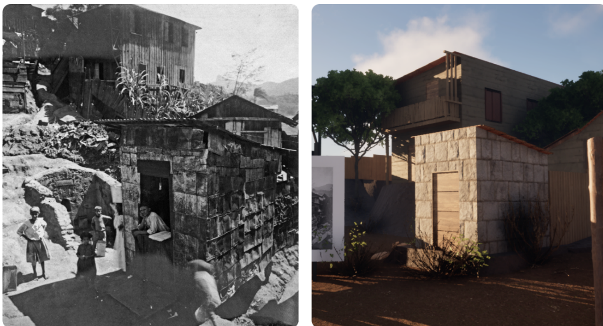
Figura 7 Comparativo entre fotografia histórica das construções da Favela de Santo Antônio e sua correspondente representação no modelo tridimensional. Fonte da fotografia histórica: Fundação Oswaldo Cruz; representação tridimensional: Autor, 2026.
