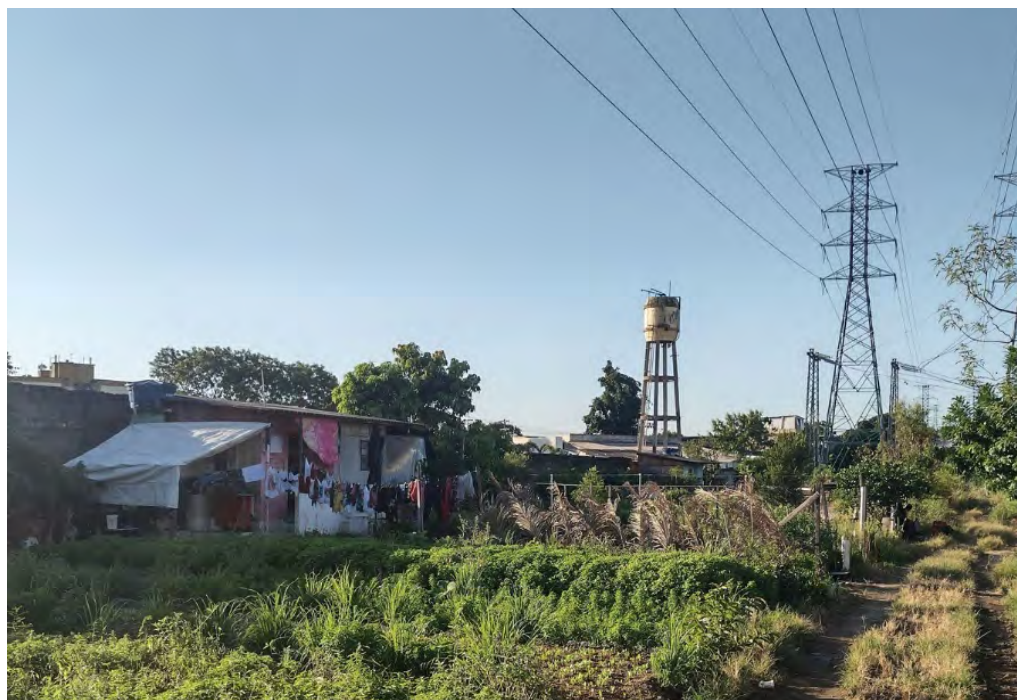
Figura 16 Interior da faixa com moradia informal, Colégio. Fonte: Juliana Sicuro, 2023.
