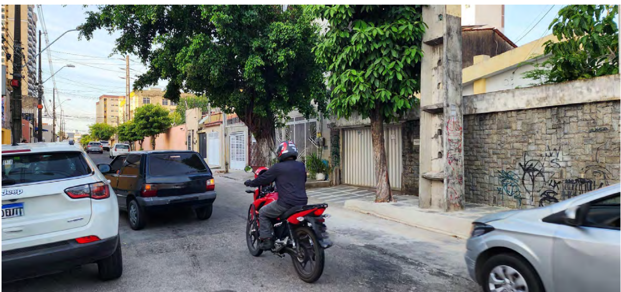
Figura 07 Calçadas com desníveis e obstáculos na R. Sólon Pinheiro. Fonte: Silva (2024) (publicação autorizada pelo autor).
