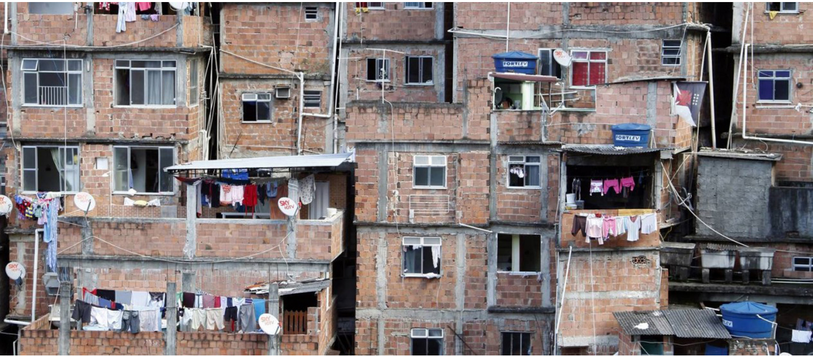
Figura 23 Típica ocupação informal em favelas brasileiras. Os edifícios são baseados em sistema construtivo simples de pilares, vigas e lajes de concreto. Fonte: www.oglobo.globo.com
