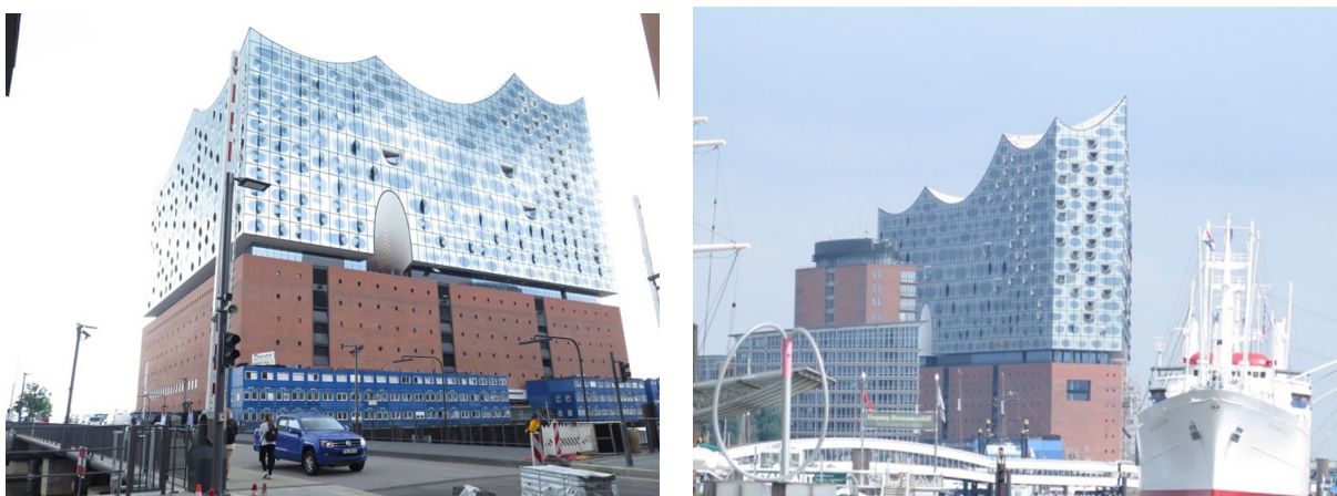
Figura 02 Elbphilharmonie, Hamburg, Herzog & de Meuron, construída sobre o Kaiserspeicher A, Hamburg, integrante da Hamburgisches Denkmalschutzgesetz (Monumentos de Hamburg protegidos por lei), do qual foi parcialmente preservado somente a caixa mural, aumentada em 2m de altura. Internamente o edifício foi totalmente destruído Fonte: Betânia Brendle, 2016
