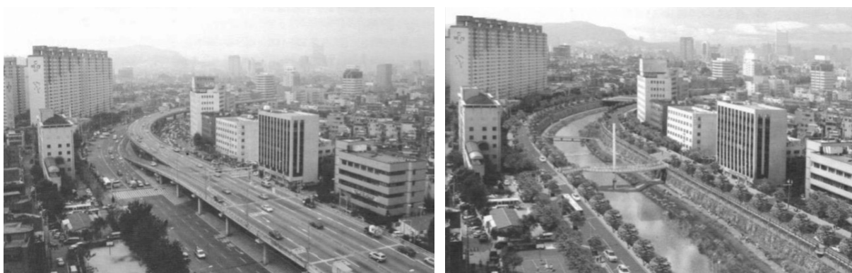
Figura 3 Recuperação do rio Cheong-Gye-Cheon, em Seul na Coreia do Sul, antes coberto pelo sistema viário da cidade. Disponível em: GOVERNO METROPOLITANO DE SEUL, 2004 apud REIS; SILVA, 2016, p. 125
