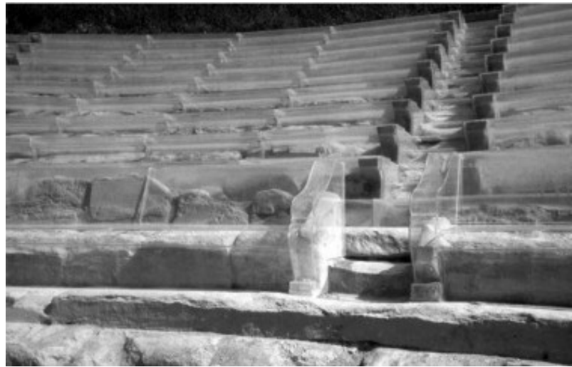
Figura 16 Eraclea Minoa (Agrigento), Teatro grego, um detalhe da proteção das arquibancadas, (hoje removida) depois da restauração (1960-63), arquiteto Franco Minissi. Fotografia: C. Bellanca, 1973. Disponível em: https://www.researchgate.net/figure/Greek-Theatre-at-Heraclea-Minoa-Agrigento-Sicily-F-Minissi-1960-63-Detail-of-the_fig9_282534153
