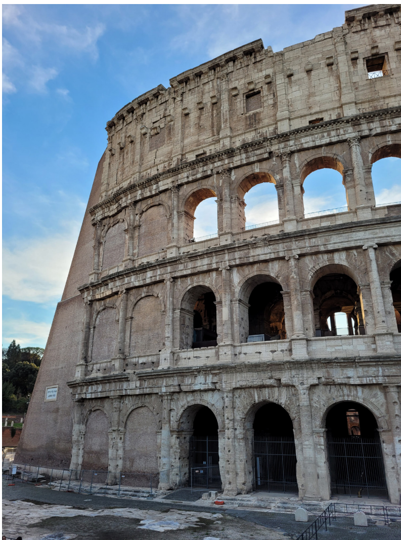
Figura 2 Roma, Coliseu (séc. I d.C.), contraforte ocidental de consolidação (1806-07), arquiteto Raffaele Stern Fotografia: Nivaldo Vieira de Andrade Junior
