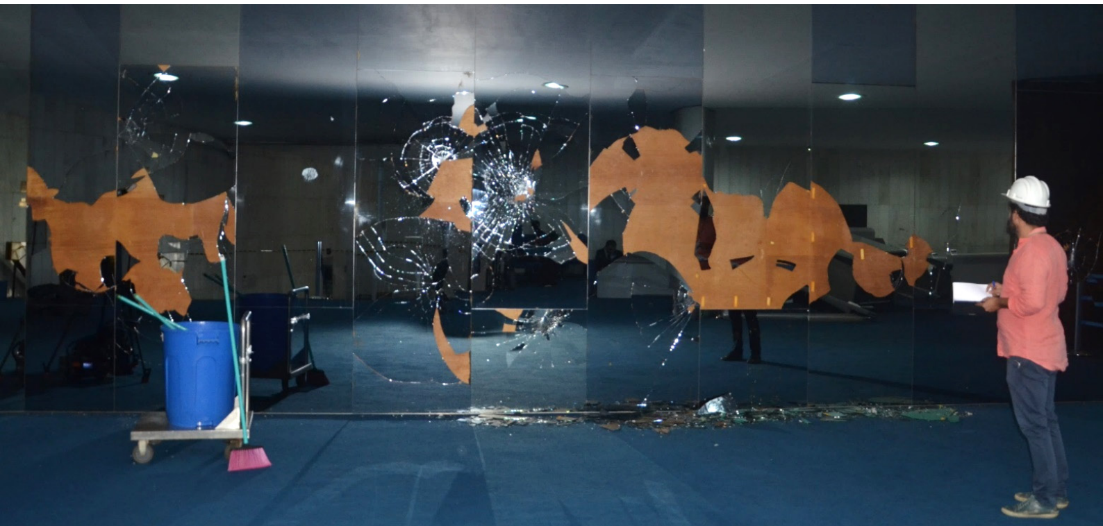
Figura 01: Paineis de espelhos do Salão Azul em 9 de janeiro de 2023. Fonte: Senado Federal/ Sinfra (2023).
