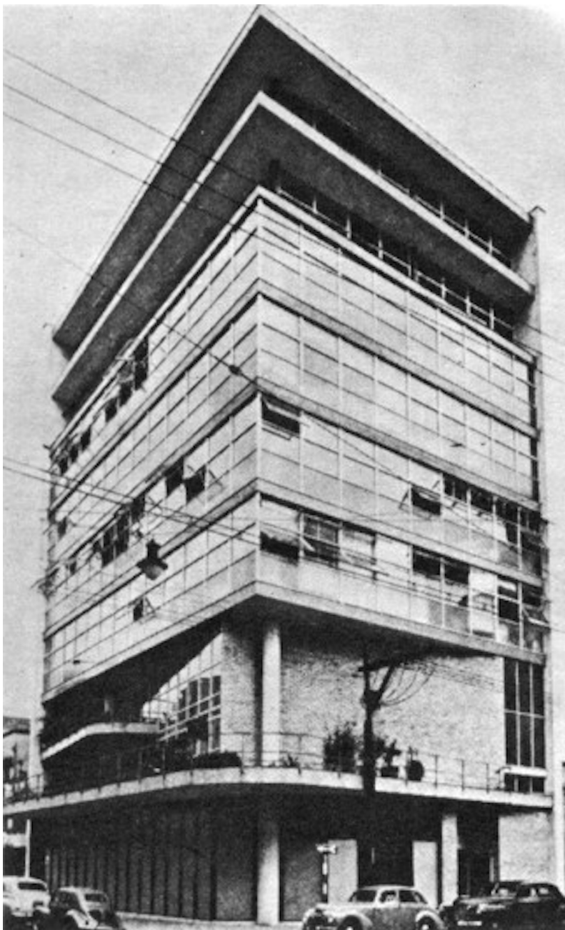
Figura 4 Fachada do Edifício. Fonte: (GUIMARAENS in Vitruvius, 2015) 12
