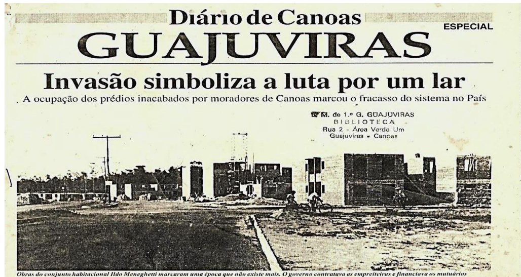
Figura 5 Imagem da obra inacabada. Fonte: Biblioteca da Escola Municipal de 1º Grau Guajuviras
